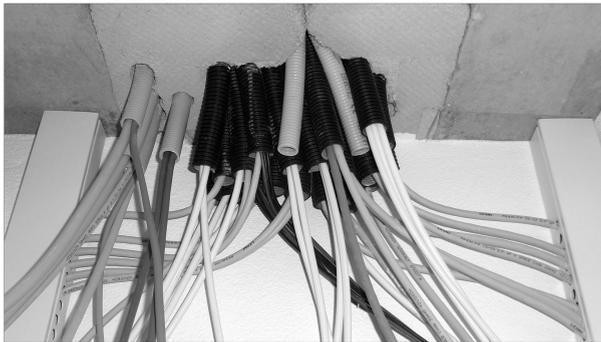
Abbildung 21.1 Sternförmige Verkabelung zu einem 19-Zoll-Rack
