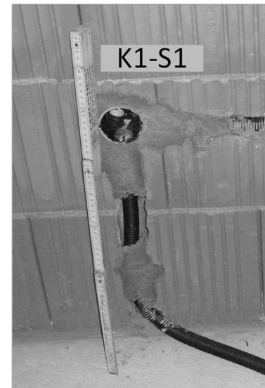
Abbildung 5.7 UP-Dose und Leerrohrführung mit Referenz auf den Leitungsplan
