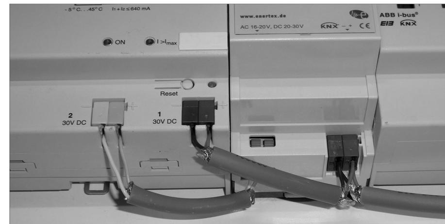
Abbildung 7.9 Aufstecken der Busklemmen auf die KNX-Geräte
