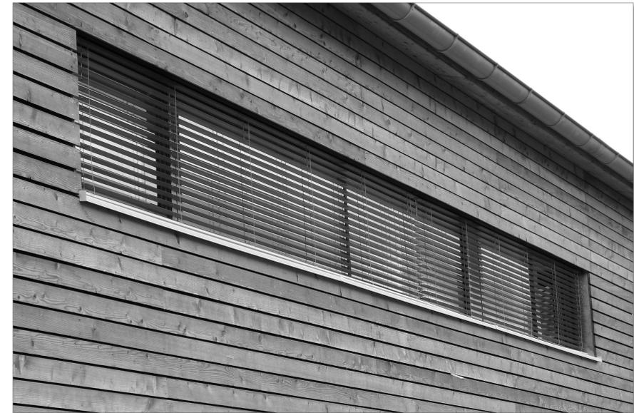
Abbildung 3.2 Außenjalousien, in die Gebäudesteuerung integriert
